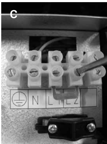
Рисунок 10 С и D. 1-фазное соединение каменки
